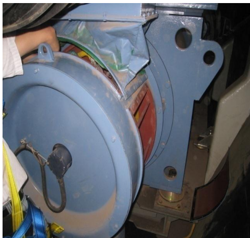
拆卸维修可拆板
